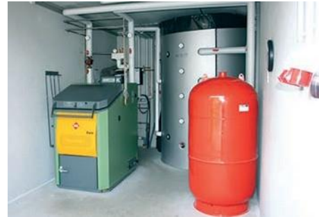
Dobry dostęp i rozmieszczenie elementów – tak prezentuje się kontener dla kotłów wsadowych.
