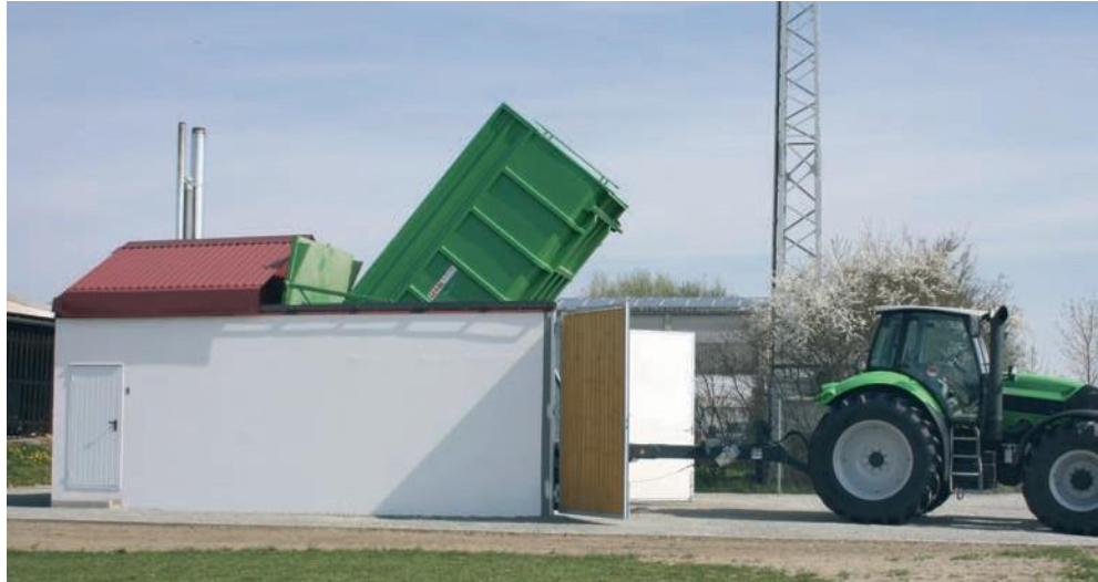
Większość gospodarstw rolnych wyposażona jest we własny sprzęt rozładunkowy dzięki czemu napełnianie magazynu jest bezproblemowe. Istotną rzeczą jest maksymalne wykorzystanie pojemności magazynu. Osiąga się to poprzez umiejętne rozsypywanie paliwa.
