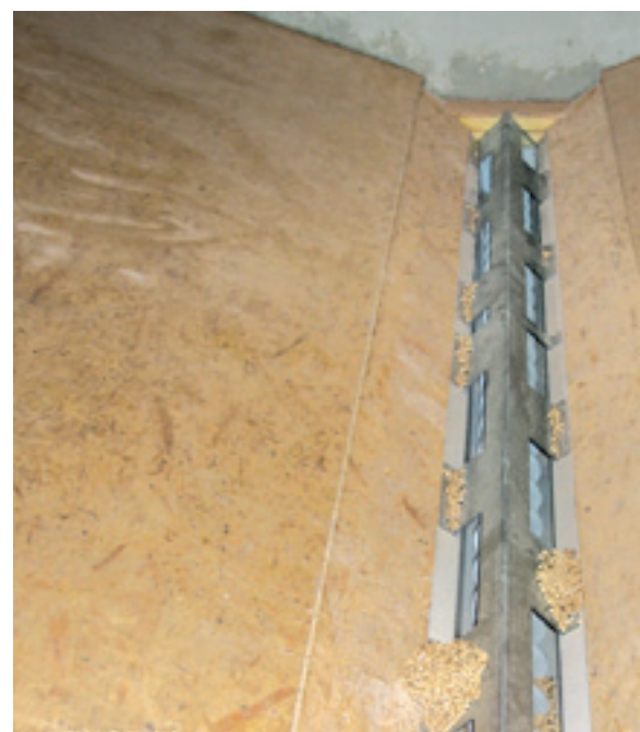
Transporter wygarniacza HDG pobiera pellet z prostokątnych pomieszczeń magazynowych.
