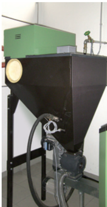
Zbiornik pośredni systemu zasysania pelletu HDG pobiera aż do 100 kg pelletu. Taka ilość wystarczy na użytkowanie urządzenia HDG Compact 50 przez ponad 8 godzin bez potrzeby ponownego napełniania.
