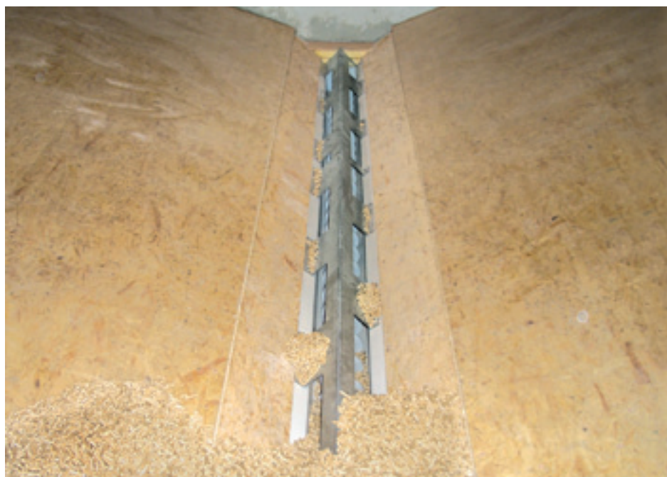
Ślimak wygarniacza HDG przenosi pellet z prostokątnych pomieszczeń magazynowych.
