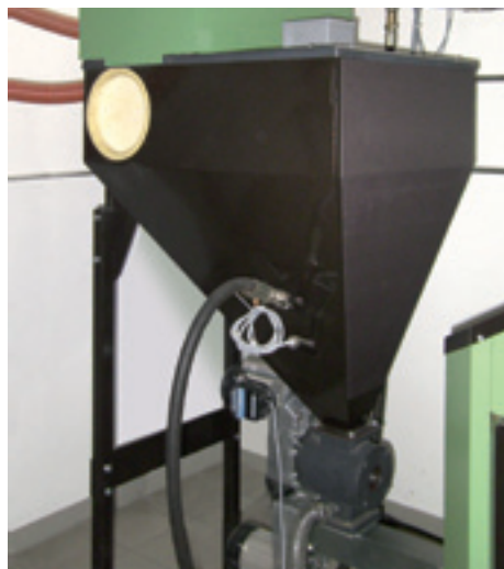
Zbiornik pośredni systemu zasysania pelletu HDG pobiera aż do 100 kg pelletu.
