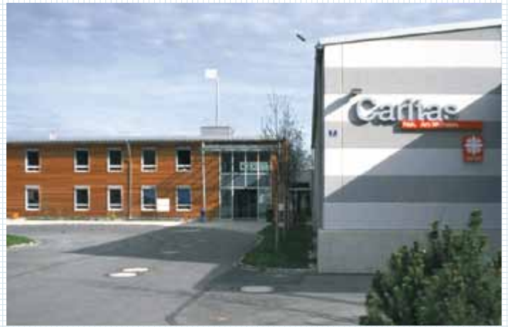
Pracownie Caritas w Obermühl (Raubling) ogrzewane przy pomocy instalacji HDG Compact 200
