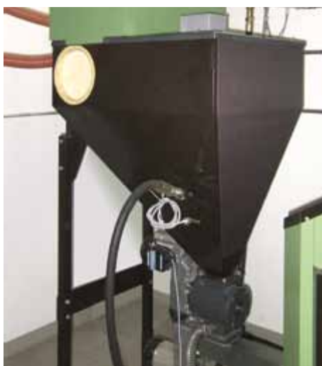
Zbiornik pośredni systemu zasysania pelletu HDG pobiera aż do 100 kg pelletu.
